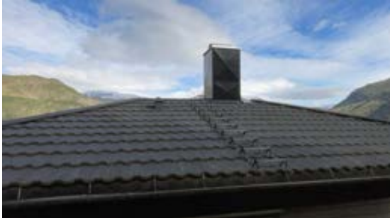
Takstige opp til pipe
