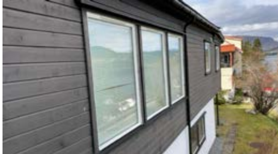
Vindu på stue
