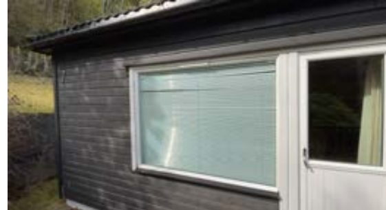
Stuevindu ved balkongdør
