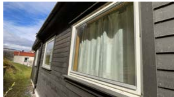
Vinduer på soverom og kjøkken
