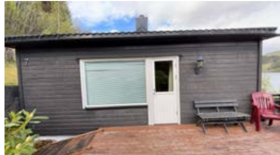
Oversikt kledning mot veranda som er skiftet
