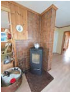
Montert plate på gulv ved sotluke
