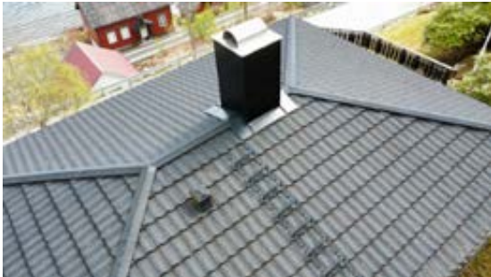
Oversikt pipebeslag, luftehatt og takstige
