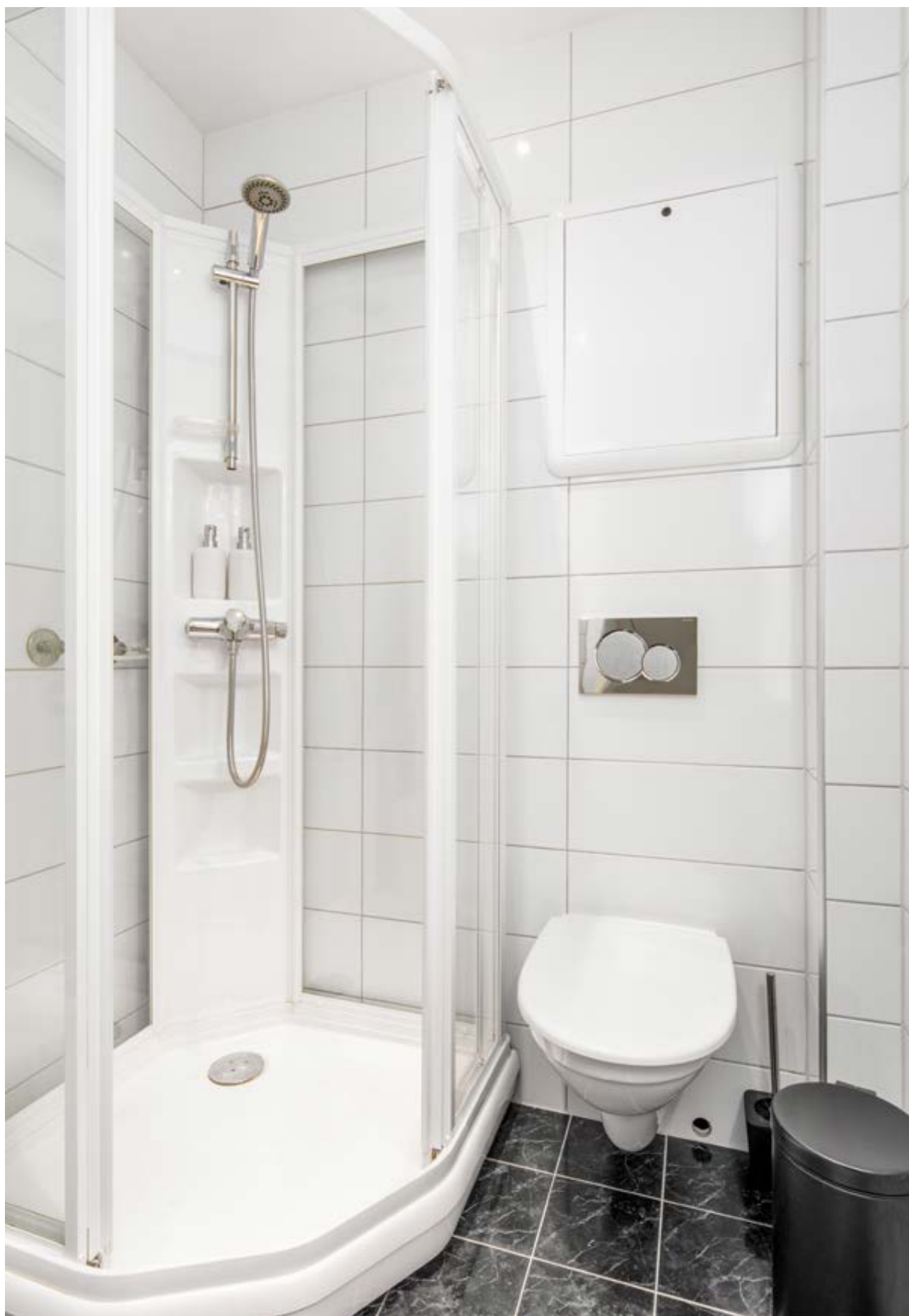
Bad med fliser på gulv og vegg.
