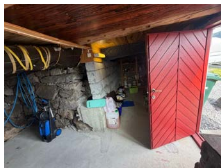
38 vektprosent i trevirke ned mot gulv. Fukt og råteskadet, dette er ikke bærende konstruksjon og kan fjernes.
