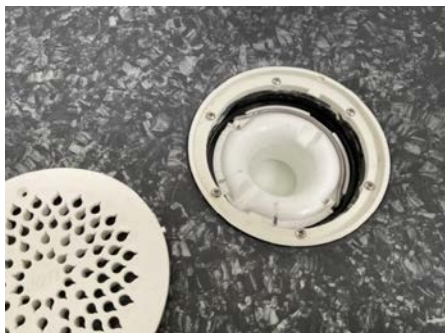
Sluk under dusjkabinett
