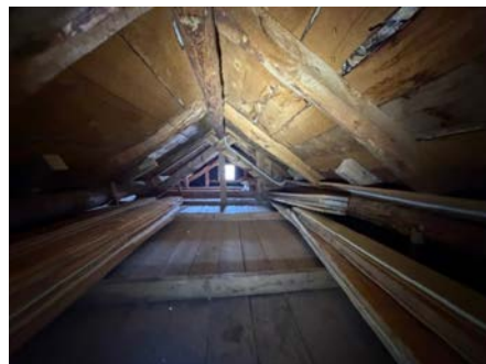
Oversiktsbilde av kaldloftet.
