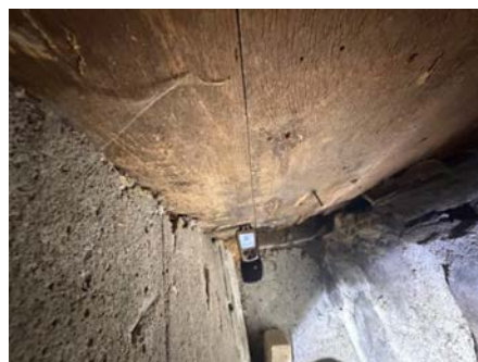
38 vektprosent i trevirke ned mot gulv. Fukt og råteskadet, dette er ikke bærende konstruksjon og kan fjernes.
