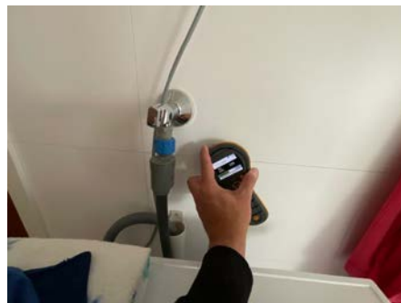
Ikke utslag på fukt ved fuktsøk.
