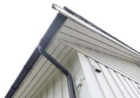
Luftespalter i kassekledning.
