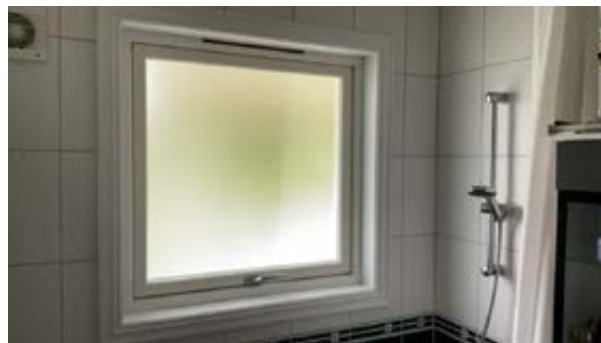
Vindu i våtzone over badekar.
