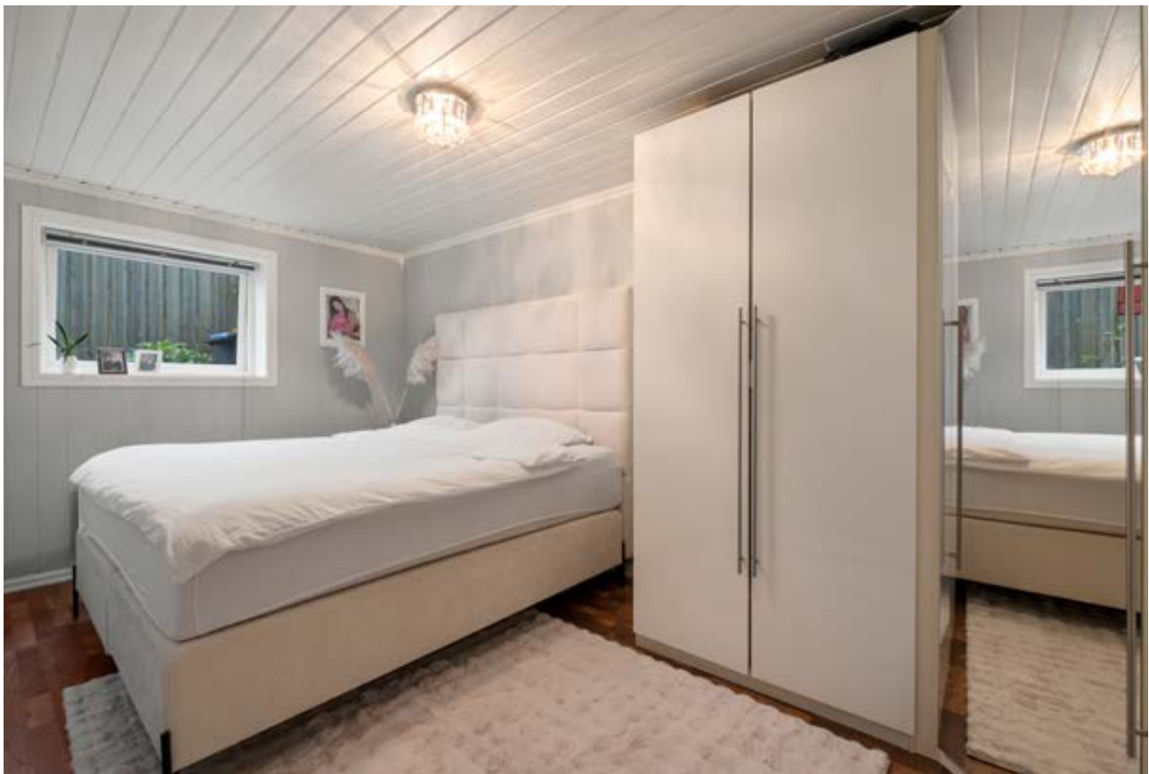
Rom brukt som soverom. Rommet er byggemeldt som bodareal (hobbyrom). Det er ikke søkt om bruksendring. Vinduet på rommet er montert f.o.m. 120 cm opp fra gulv. Avstand fra gulv til underkant av vindusåpningen bør være maksimalt 1,0 m
