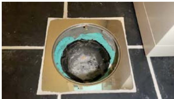
Plastsluk og synlig smøremembran.
