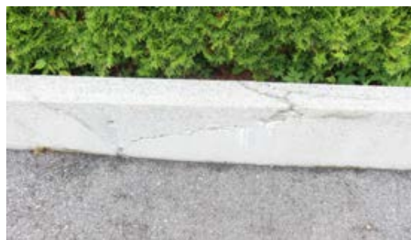
Forstøtningsmur langs innkjørsel
