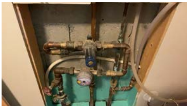
Synlig tørr mur i inspeksjonsluke/utsparing
