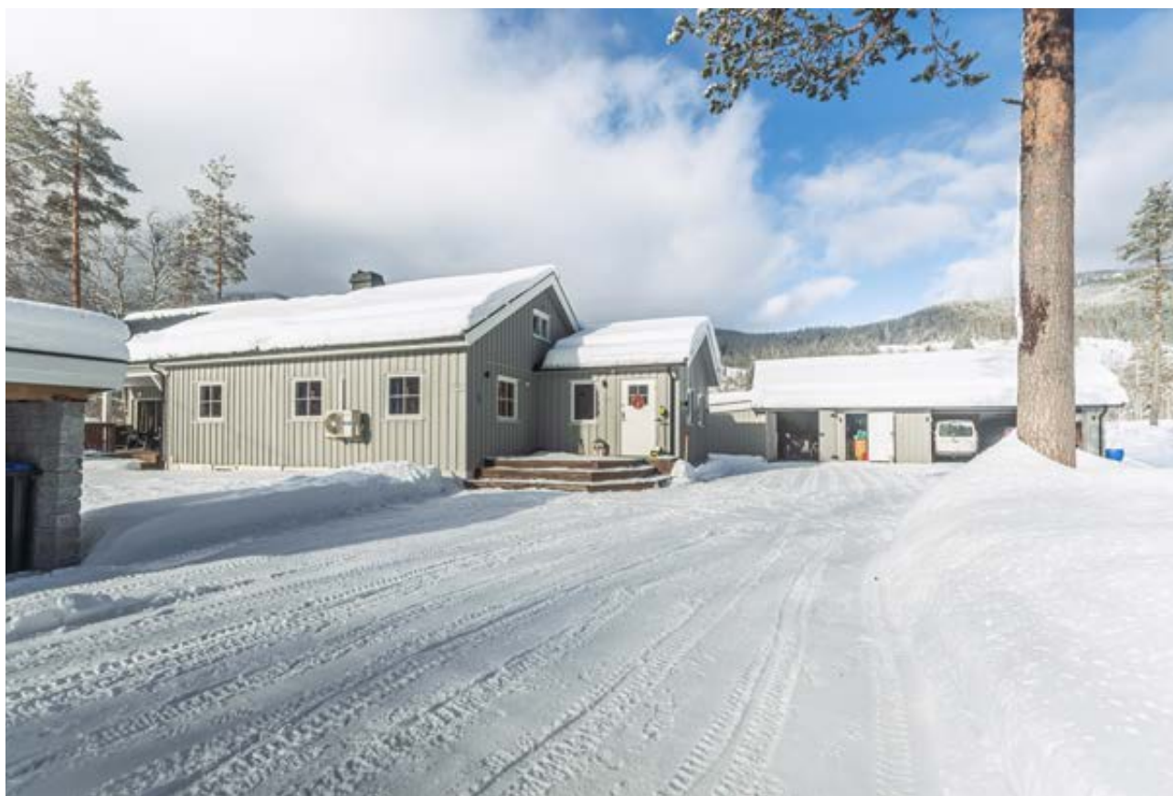
Bygningen har stående bordkledning og malte trevinduer med 2- og 3-lags glass.
