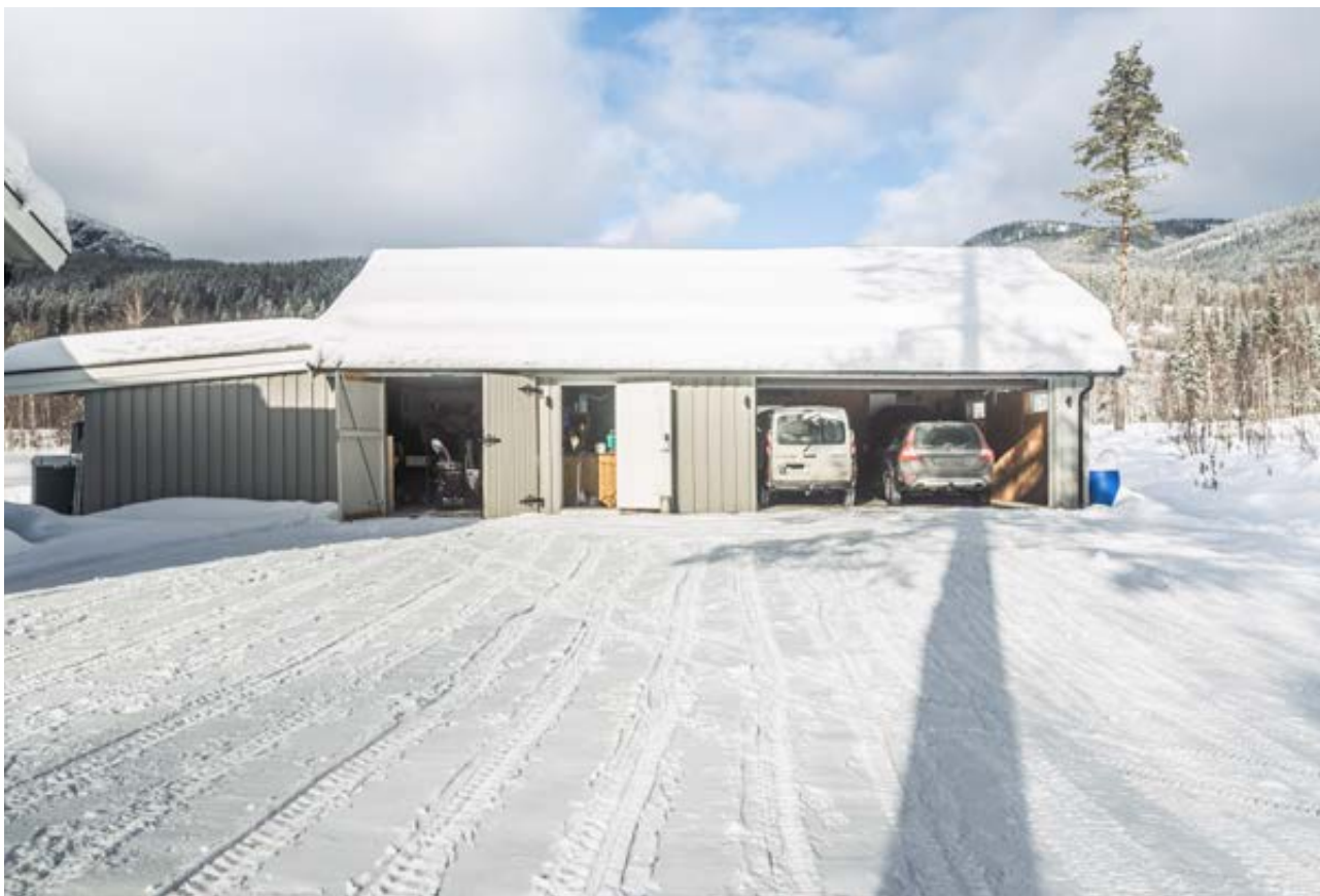
Garasje med godkjente tegninger og ferdigattest, bygget i 2014, tilbyr romslig plass for biloppstilling og oppbevaring.
