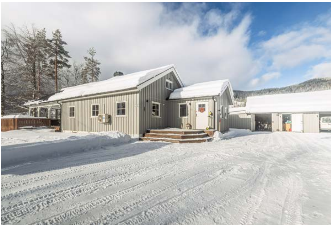
Gruset adkomst og gårdsplass gir enkel tilgang til boligen, som har malt hovedytterdør fra 2009.
