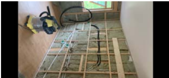
Vegg var åpnet i 2022, ved montering av nytt kjøkken.
