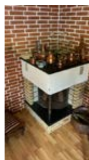
Peis i kjellerstue, ildfast plate på gulv mangler
