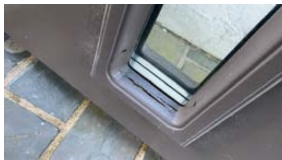
Dør er værutsatt, tegn til posning
