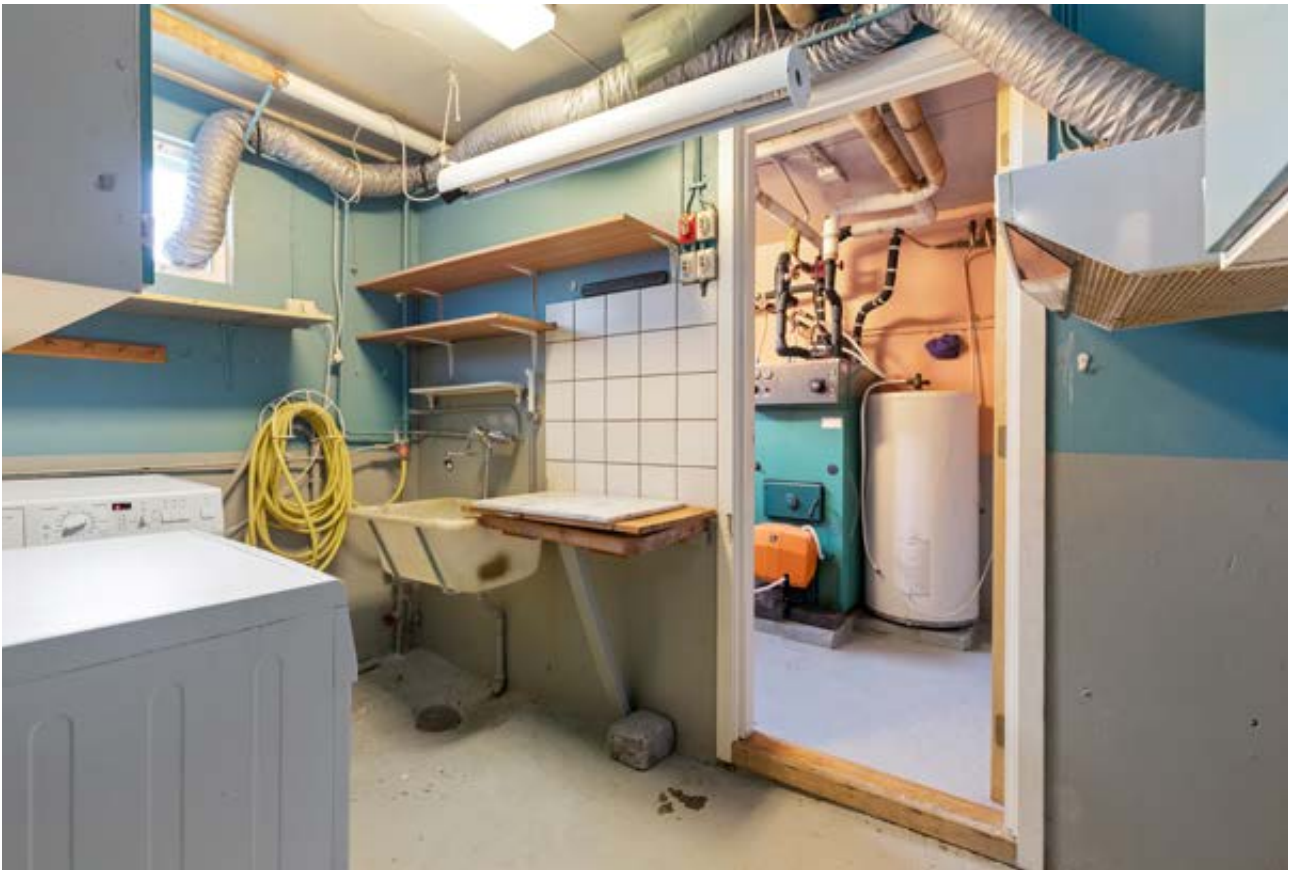
Vaskerommet i underetasjen har betonggulv og malt mur på veggene, samt opplegg for vaskemaskin og vaskekar
