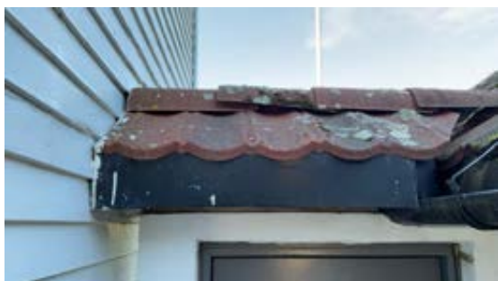
Detalj leder vann inn mot vegg/kledning
