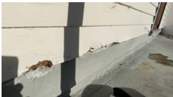
Sørvegg, råteskade
