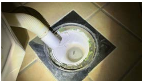
Sluk på bad i 1. etasje
