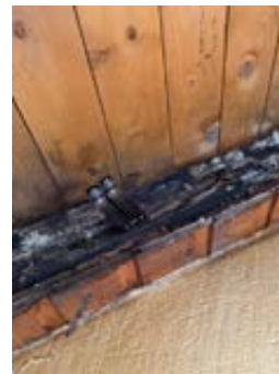
Det var mulig å stikke kniv med håndmakt inn i treverket.
