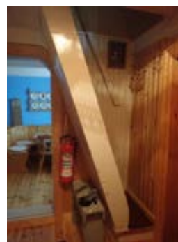
Rekkverk mangler. Må monteres.
