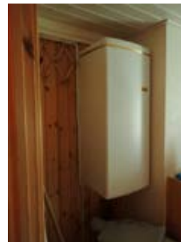
60 l vvb montert på vegg på bad.
