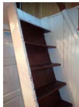
Rekkverk mangler. Må monteres.
