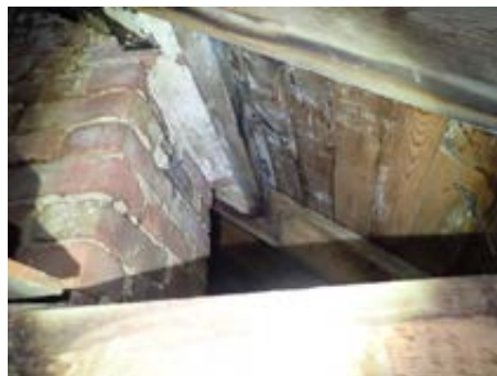
Fukt/råteskadet trobord
