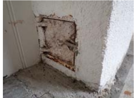
Feieluke er plassert nært brennbar material på vegg
