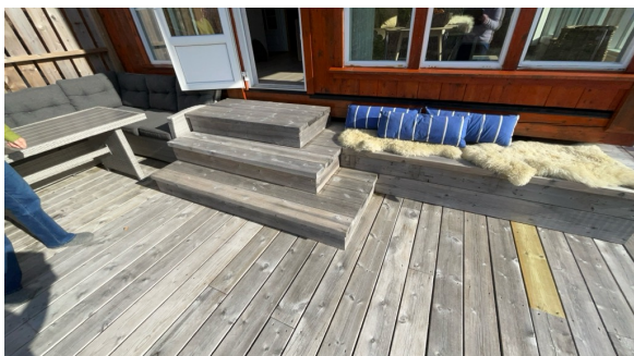
Trapp ved balkongdør.
