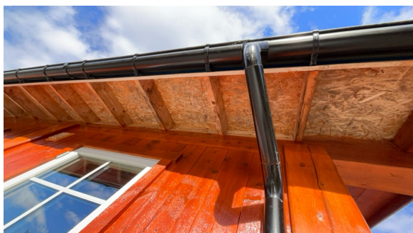
Synlig lufting ved takrennekroker.
