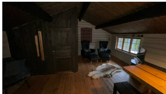
Takkonstruksjonen har sperrekonstruksjon med takåser av rundstokker og sperrer.
