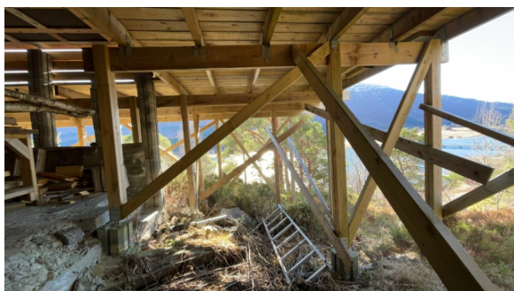
Byggegrunn av fjell.
