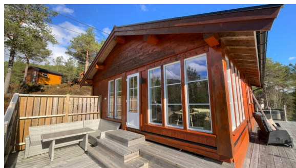
Taket er med saltaksform. Takkonstruksjonen har sperrekonstruksjon med rammeverk av stavlaft, takåser og sperrer.
