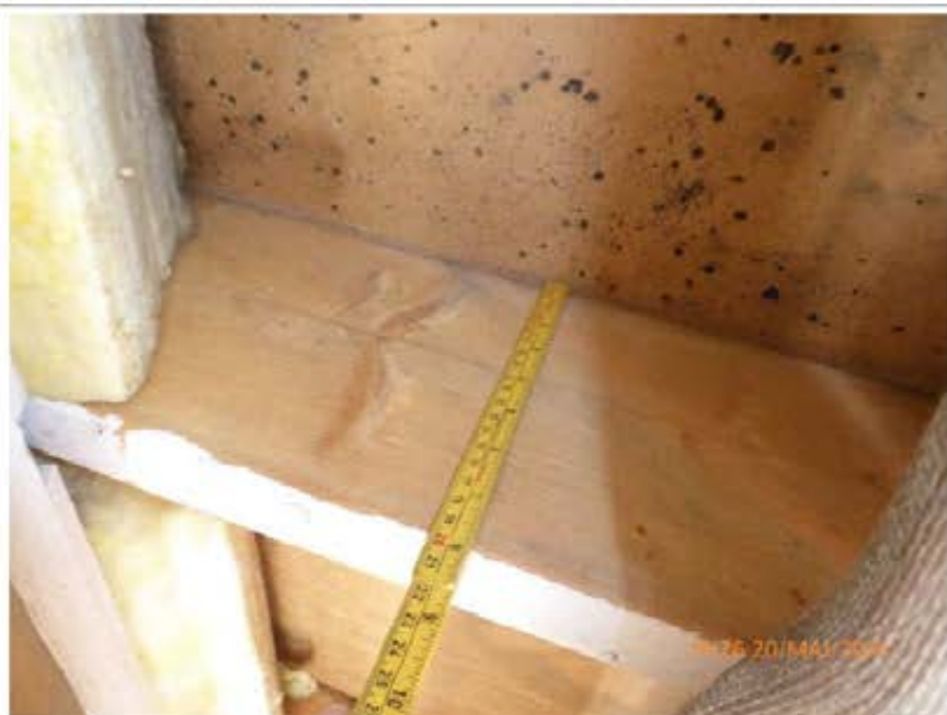
Takbjelker med dimensjon 36x198.
