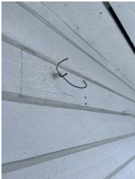
Uisolerte ledninger utvendig
