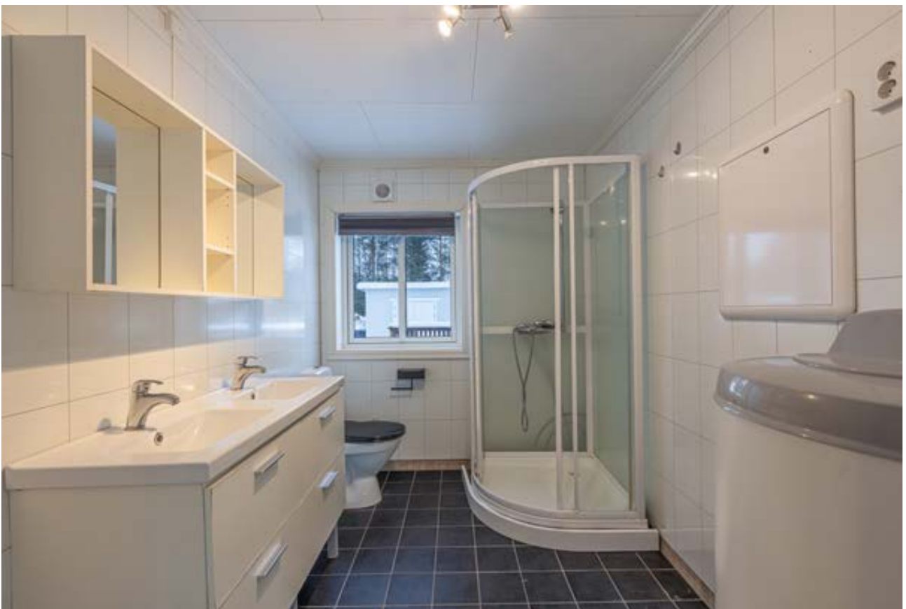
Bad innredet med wc og dusjkabinett.
