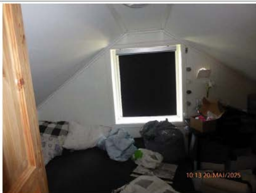
Ettermontert ventil soverom loft.
