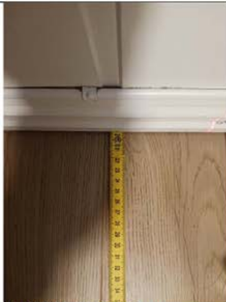
Glippe under fotlist 2.et. Avlest 198mm
