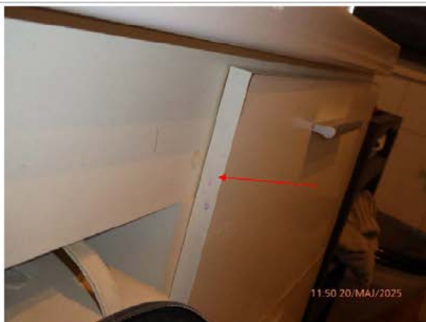
Rennemerker på siden av skuffefront etter vannsøl.
