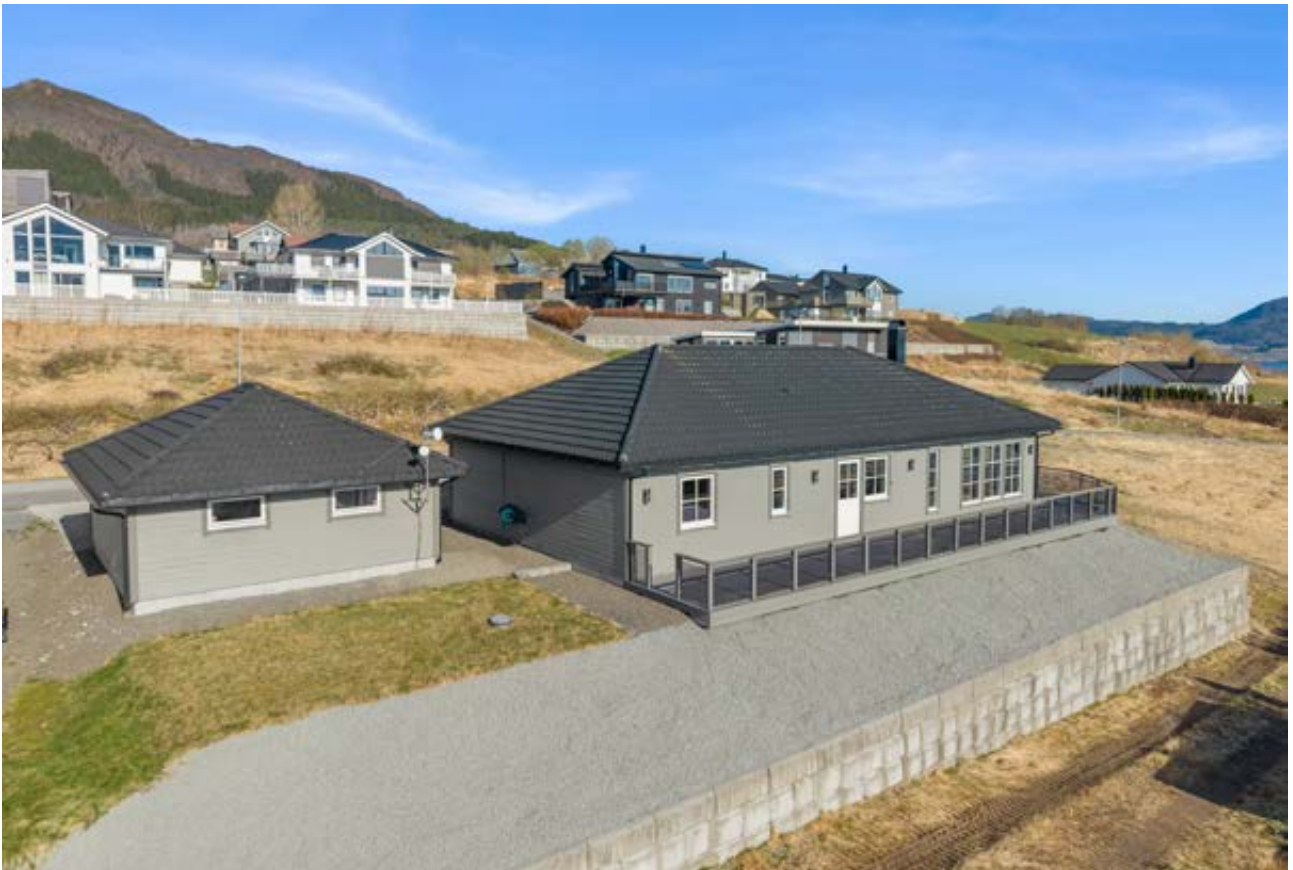
Eiendommen er også pent opparbeidet med blant annet plen og forstøtningsmur
