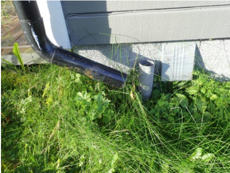
Ikke tilkoblet drenering.
