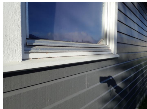
Vindu type Nordan - innad slående med 3 veis lukke/åpne funksjon
