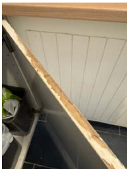
Delaminering av belegg på skapdør.
