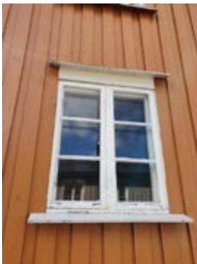
Oversiktsbilde av vindu utvendig
