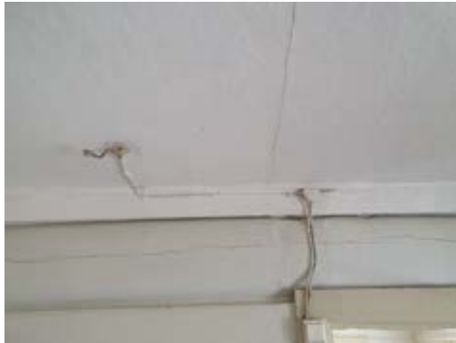
Uisolert ledningsende ligger åpent i innvendig tak.
