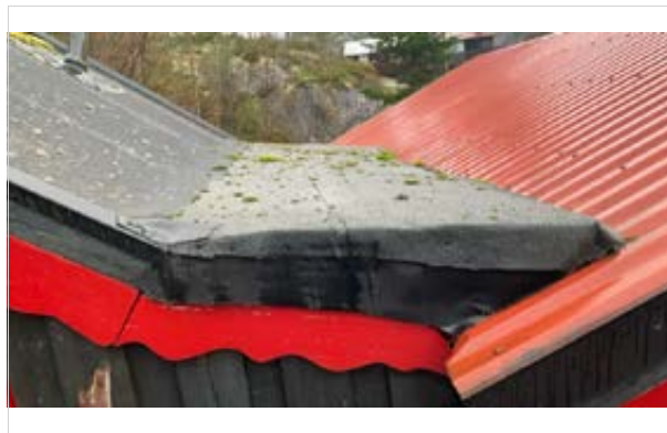
Ingen faglig anbefalt løsning på overgang.
