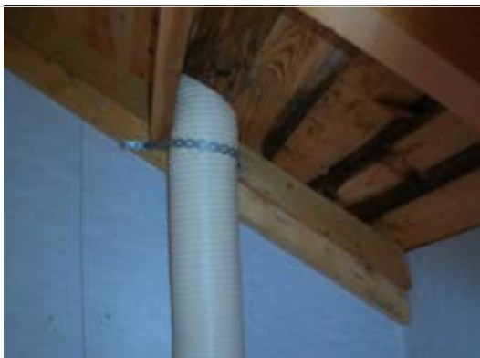
Taktro er fuktige på underside, trolig som følge av lekkasje i gjennomføring av kanal.
