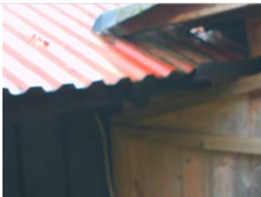
Overgang mellom papp tekking og takplater
