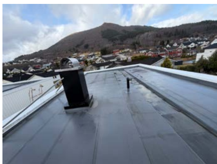
Oversiktsbilde av taktekking.
