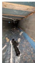
Oversiktsbilde av krypkjeller og avslutning av plast.
