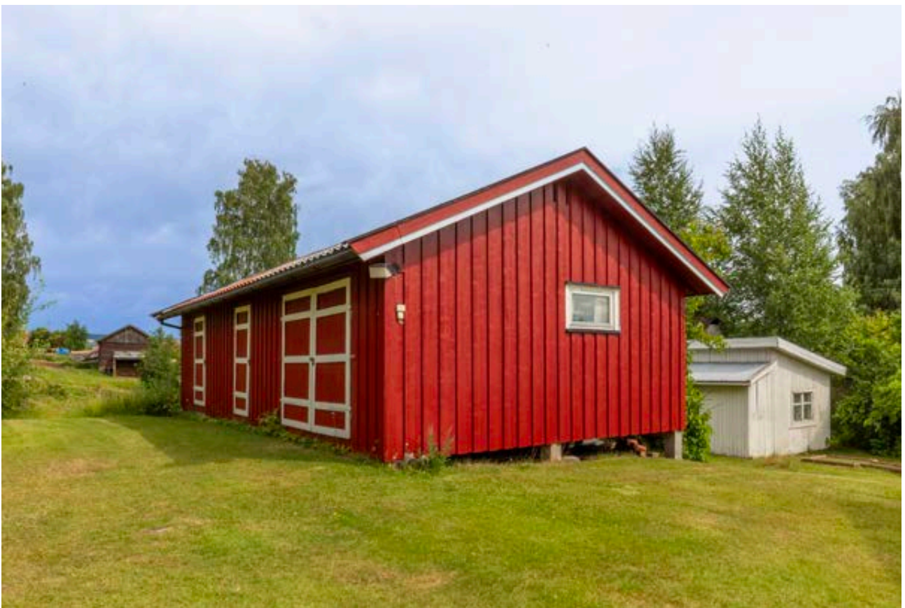
Garasjen med to boder er i dag i bruk som lager, men bygningen har god standard og kan enkelt brukes til andre formål. Foto-Olsen
