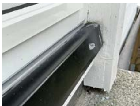
Beslag på terskel til bi-inngang/vaskerom.
