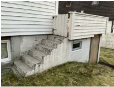
Rekkverk til trapp er ikke etablert.
