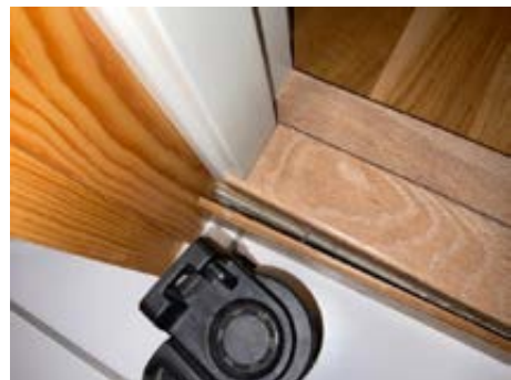
Membran oppkant ved dørterskel.
