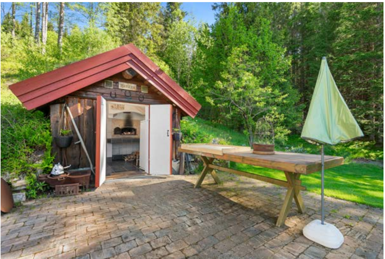
Bakehus delvis gravd inn i bakken med vedfyrt bakerovn
