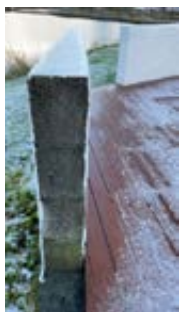
Eksempel på gjenstående arbeid/avslutning
