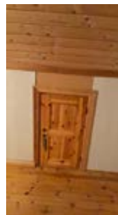
Gjenstående arbeid rundt kottluke
