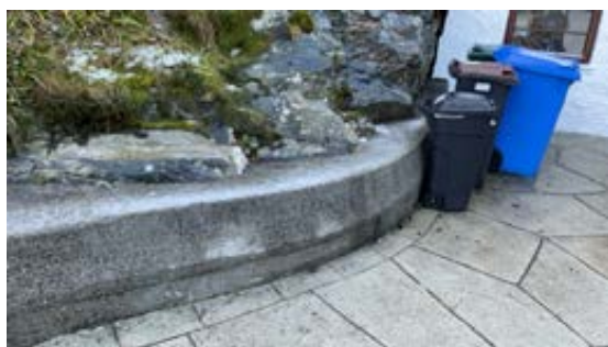
Murkant ved garasje
