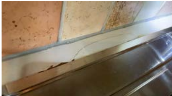
Skade benkeplate
