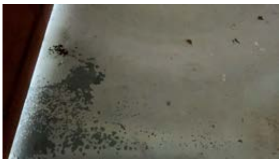
Stedvis avflassa/avslitte overflater gulv
