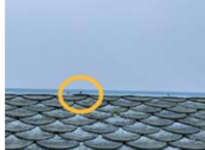
Korrosjon mønebeslag
