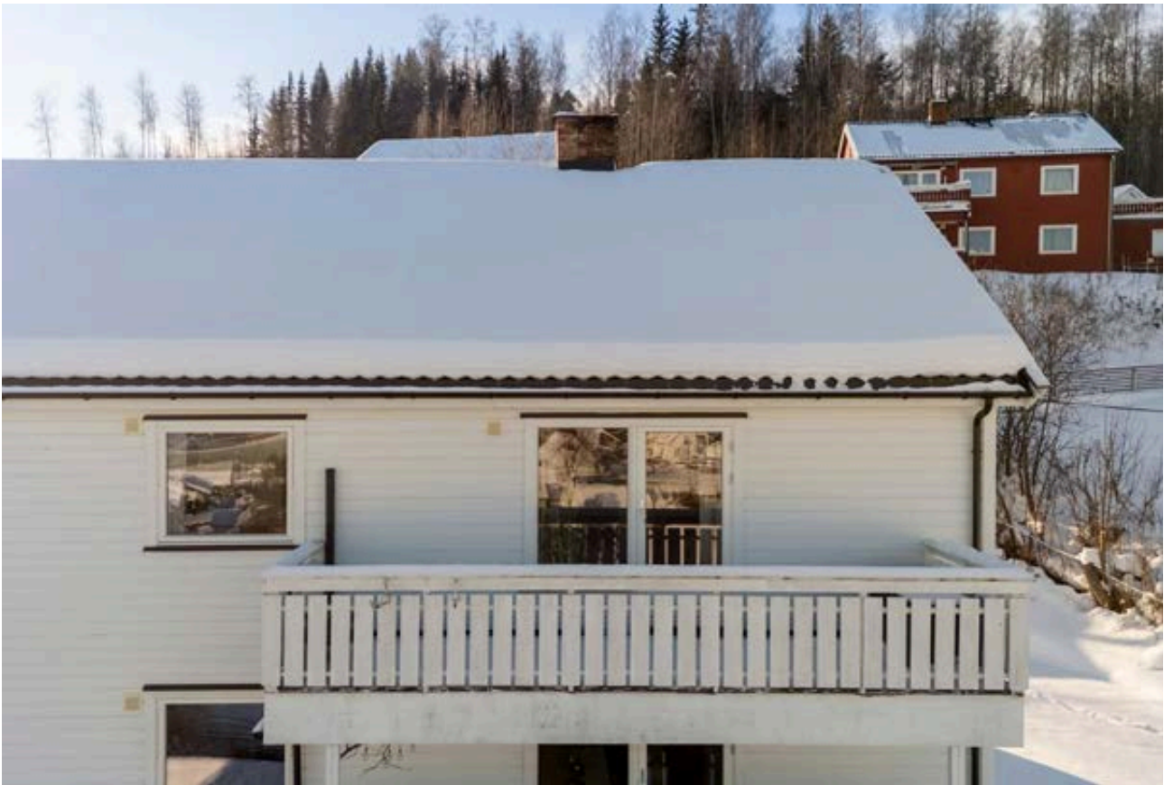
Balkong fra stue.
