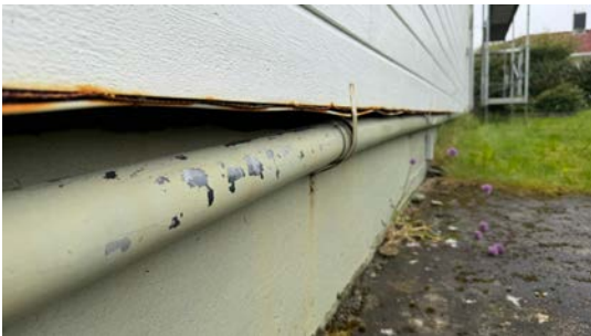
Nedløpsrøret på nordsiden går lang kledningen
