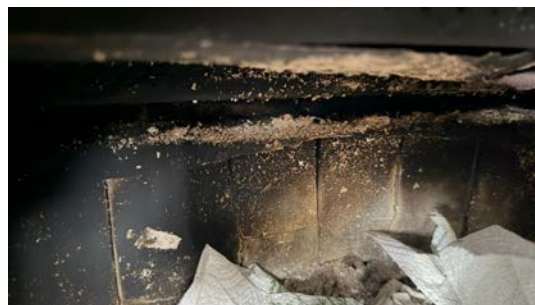
Skader på den ildfaste stenen i peisen
