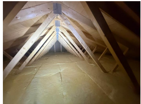
Oversiktsbilde av kaldloftet i tilbygg.
