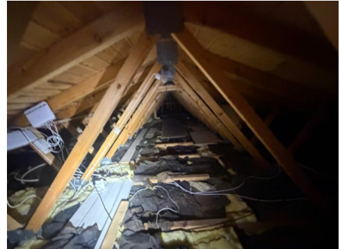
Oversiktsbilde av kaldloftet i opprinnelig del.
