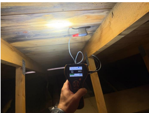
Fuktmåling i undertaket. Ikke utslag på fukt.
