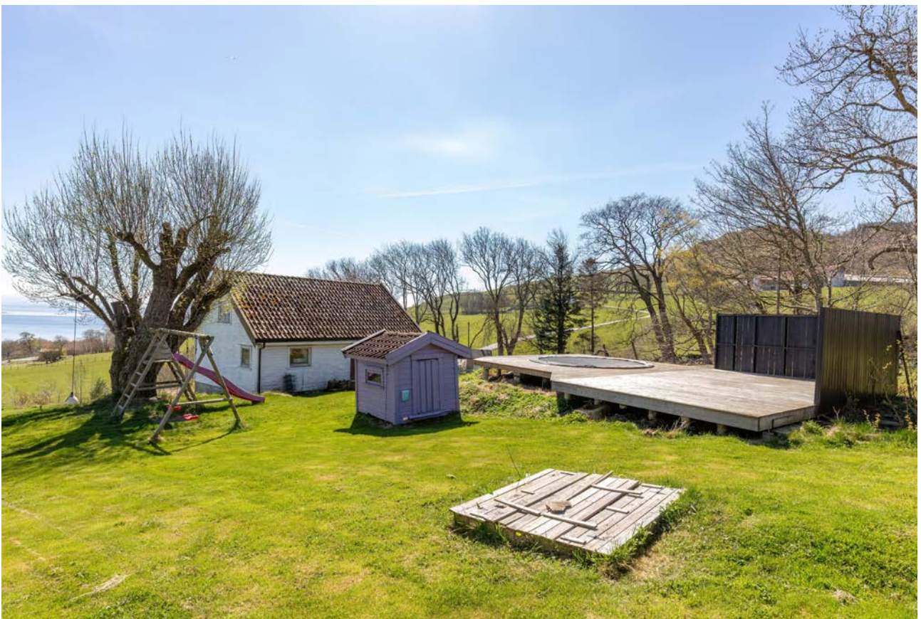
Våningshus - behov for renovering
