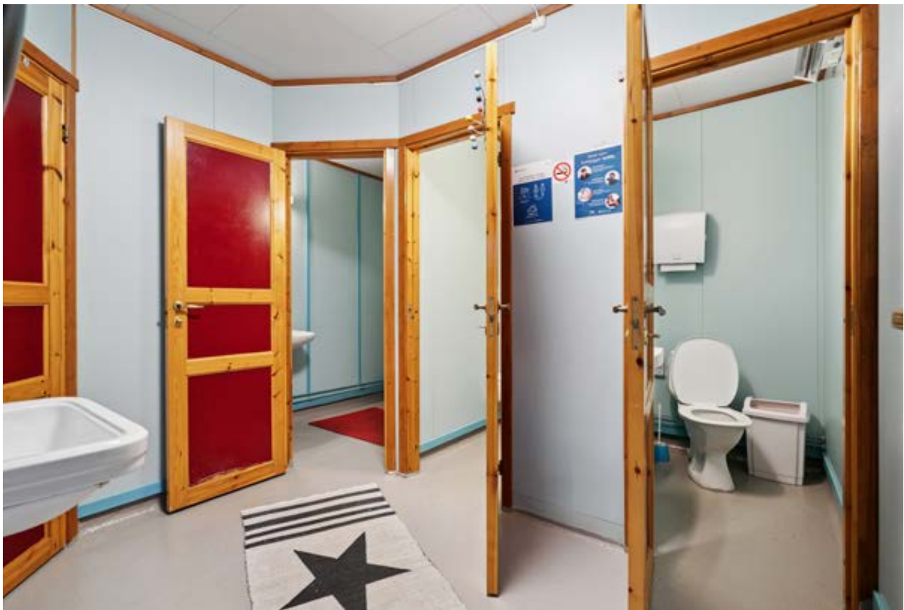
Sanitæranlegg i Servicebygget
