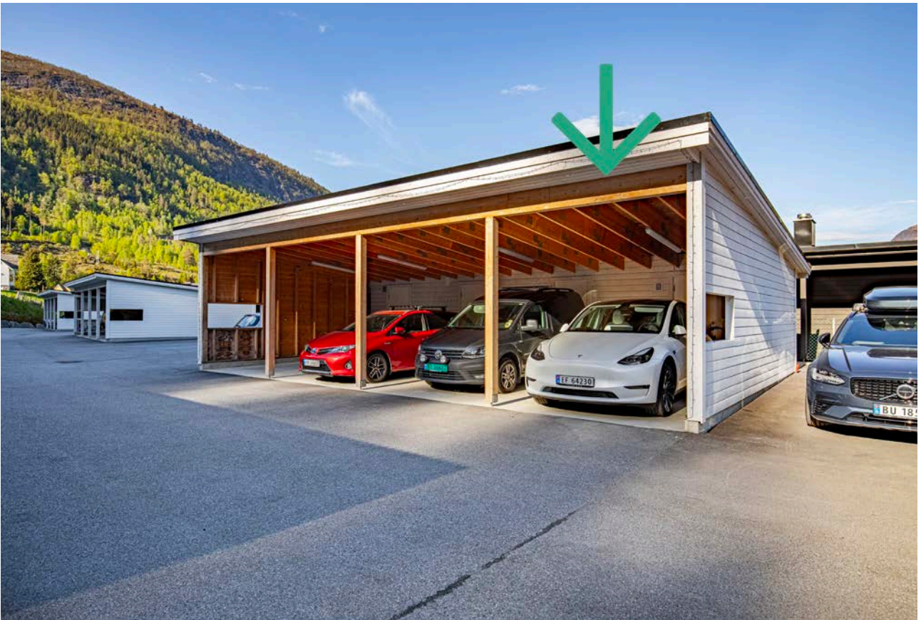
Carport med el-billader installert
