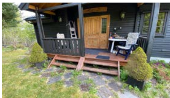
Trapp ved inngangsparti.
