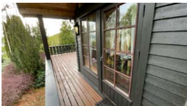
Balkongdører med lav brystning.
