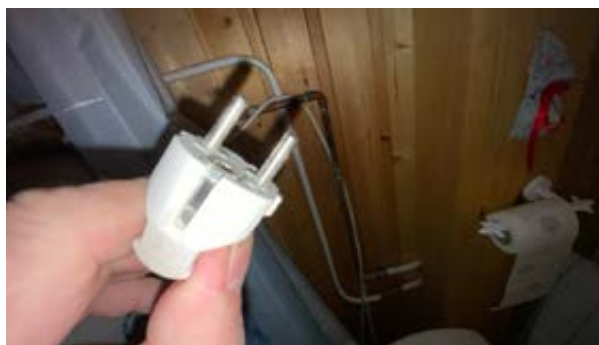
Ingen svimerker på stikk ved dagens befaring.
