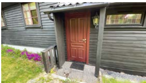
Biingangsdør til stue nord.
