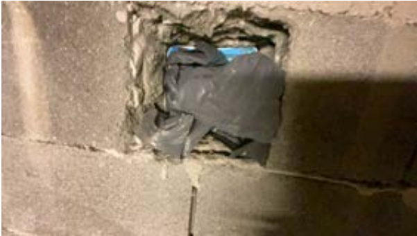
Ventiler er tette med tanke på årstide.
