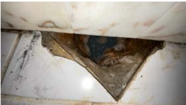
Støpejernssluk delvis under badekar.
