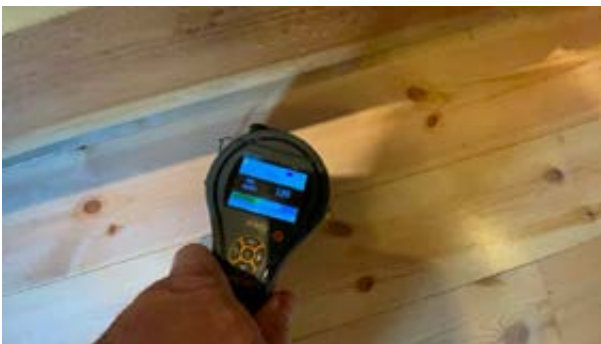
Ingen unormale fuktverdier nedenfor vask ved bruk av fuktindikato på gulv.
