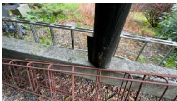
Fundamenterert på kreosotpåler på grunnmur av betong.
