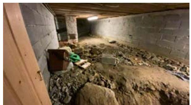
Krypkjeller med belysning.
