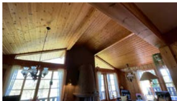
Takkonstruksjon tilbygg stue
