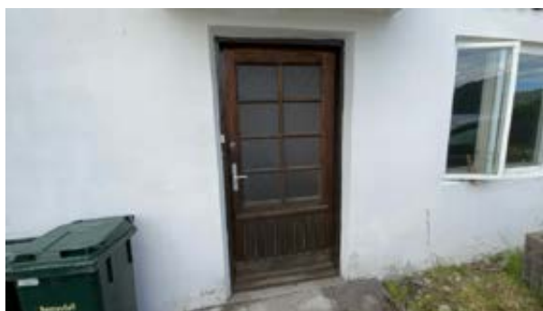
Inngangsdør mot øst med 1-lags glass.
