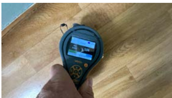
Ingen forhøyede verdier ved bruk av fuktindikator nedenfor oppvaskkum
