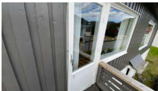
Balkongdør med 2-lags glass mot øst.
