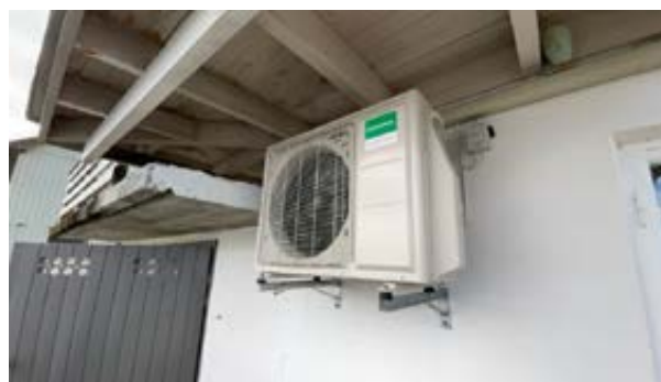
Utvendig varmepumpe.
