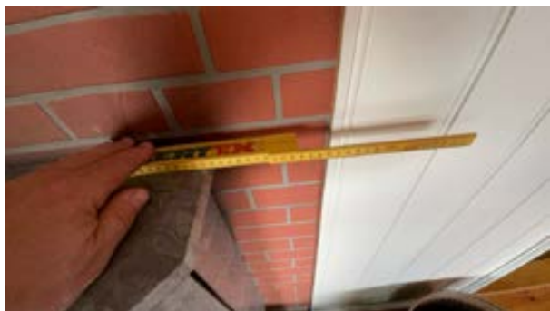
Ikke 300 mm til brannbart materiale.
