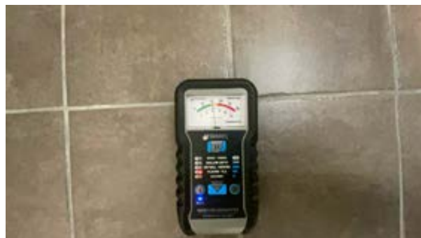
Bruk av fuktindikator på gulv.
