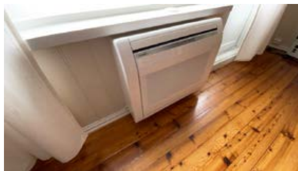
Innvendig varmepumpe.
