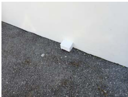
Viser ventil til krypkjelle r på østsiden
