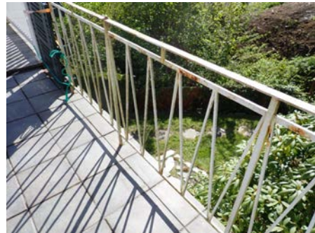
Rustskader rekkverk
