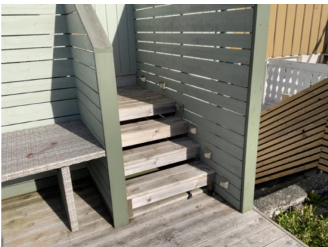
Trapp fra 1. Etasje ned på markterasse.
