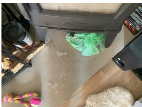
Ikke tilfredstillende avstand til brennbart materiale i front.
