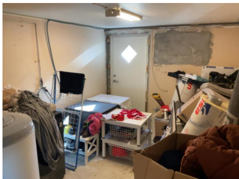
Vaskerom i kjeller.
