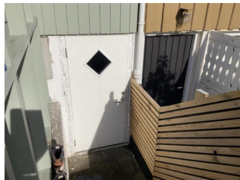
Kjellerdør med glass.
