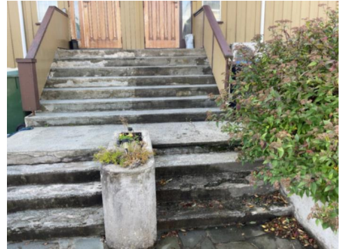
Felles inngangstrapp i plasstøpt betong mot kommunal vei.
