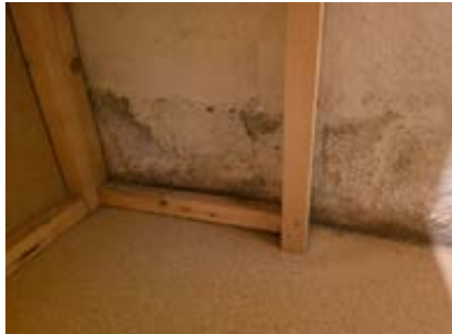
Synlig misfargning på nedre del av mur og dekke
