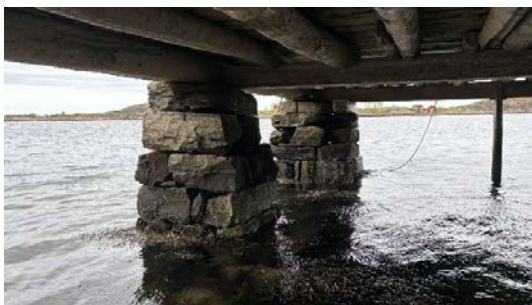
Søylefundament av frilagt stein på berg/fjell.
