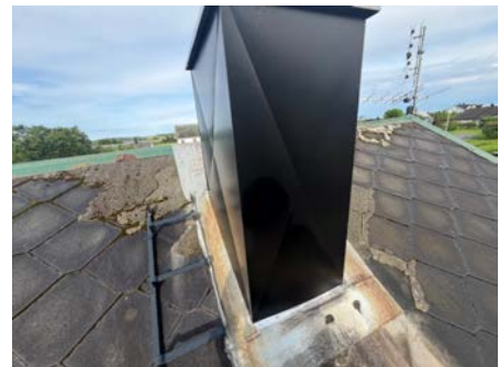
Skorstein ovet tak.
