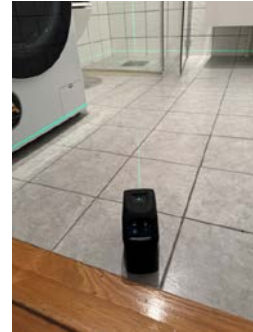
Kontroll med krysslaser av høydeforhold
