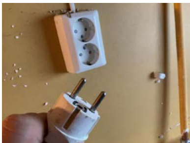
Ingen svimerker på stikk ed dagens befaring.
