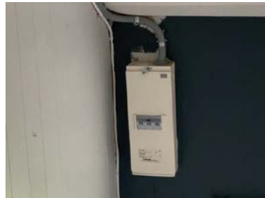
Oppgradert inntakssikring.
