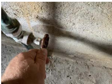
Stoppekrane er ikke funksjonell.
