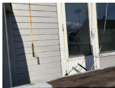
Balkongdør med 2-lags glass og lav brystning.
