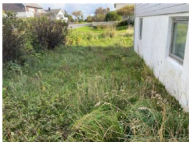
Terreng heller inn mot grunnmur på nordsiden.
