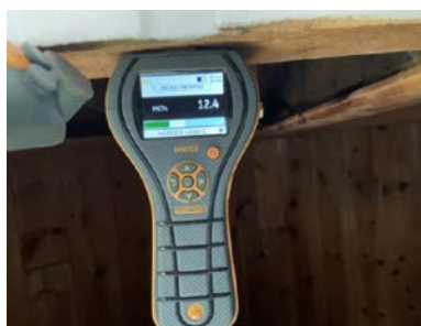
Fuktkontroll ved piggmåling viste 12,4 vekt% fukt i takkonstruksjonen som er innenfor anbefalte grenseverdier.
