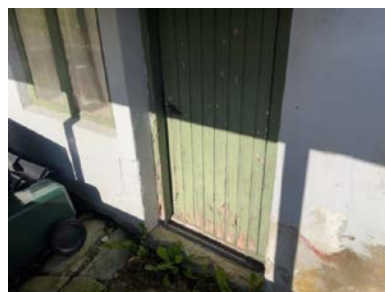
Malt tredør inn til sokkeletasje.
