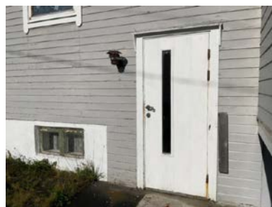
Malt ytterdør med 2-lags glassfelt.
