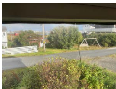
Flere punkterte vinduer i boligen.
