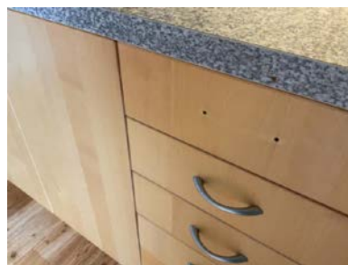
Noen fronter mangler håndtak.
