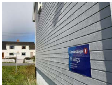
Oppdatert bordkledning på vestvegg, dato er ukjent.
