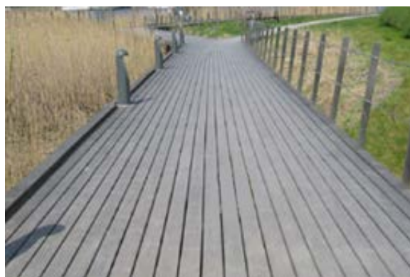
Figur 23: Tre kan vere eit alternativ i ulendt terreng. Materialet gjev stabilt, jevnt dekke med liten fare for blending.
