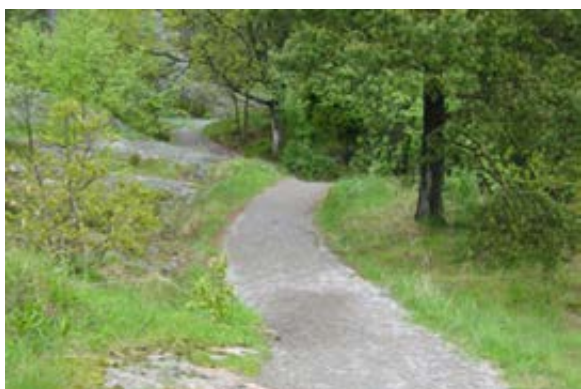
Figur 22: Sti med tettpakka fin grus (subus) i topplaget gjev god tilgjenge for barnevogn, rullestol, sykkel og elektrisk skooter.
