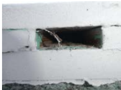
Musesperre må monteres på hulrom bak kledning
