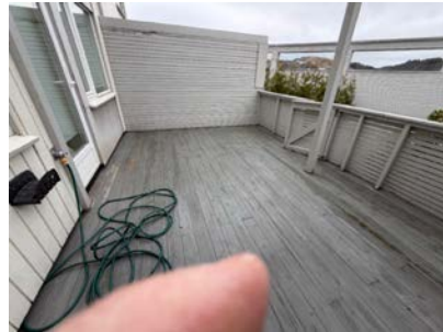
Terrasse/platting ved underetasje. Port henger.
