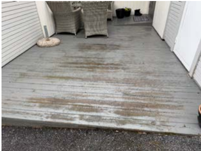
Terrasse/platting ved inngang.
