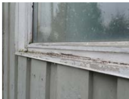
Råteskadet vindu
