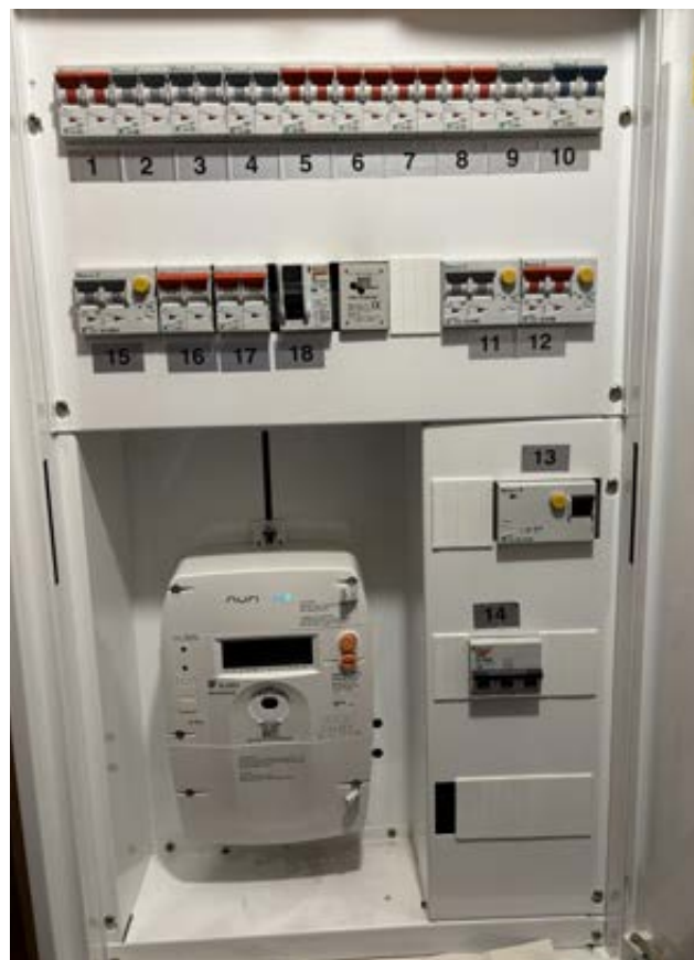
Sikringsskapet m/automatsikringer
