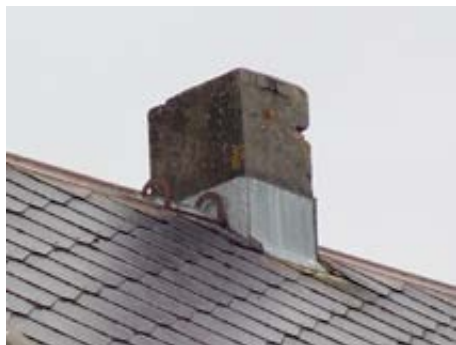
Pipe tegl pusset over halv beslag
