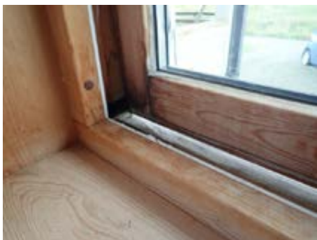
Fukt/råteskadet vindu
