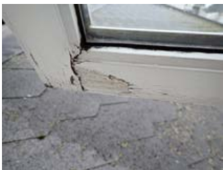
Fukt/råteskadet vindu
