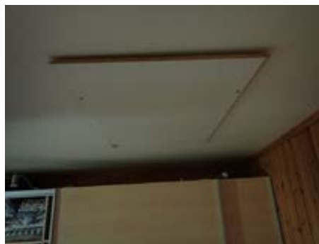
Plate er skruet fast under åpning til kvist
