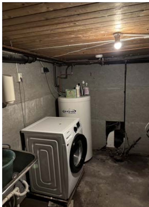
Vaskerom i kjeller
