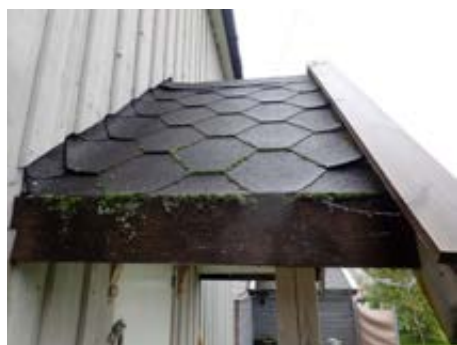
Råteskadet takrennebord.
