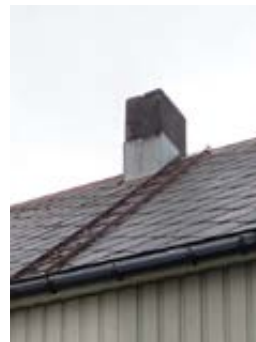
Pipe tegl pusset over halv beslag
