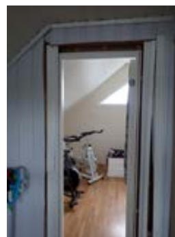
Ikke ferdigstilt med lister/foringer
