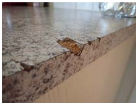
Skade i benkeplate
