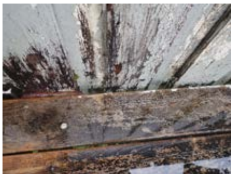
Råteskadet bordkledning.
