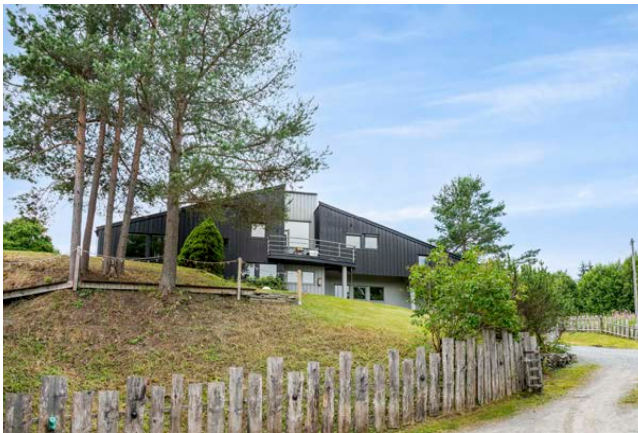
Eiendommen sett fra innkjøring fra Stensjordvegen.
