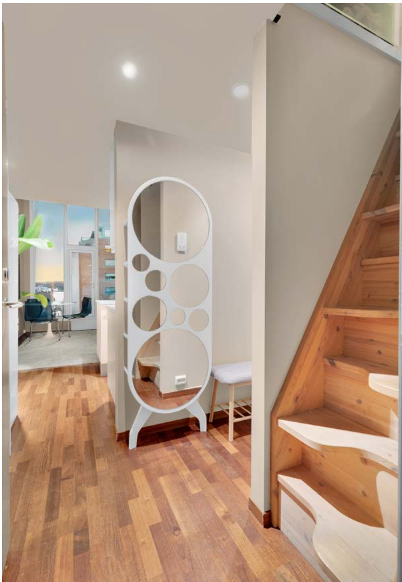
Entrè/gang. Trapp til hems tilfredsstiller ikke dagens krav for trapp til rom for varig opphold
