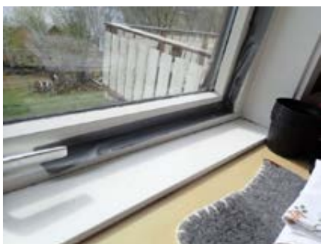
Fukt/råteskader.
