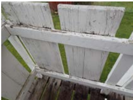
Råteskadet rekkverk
