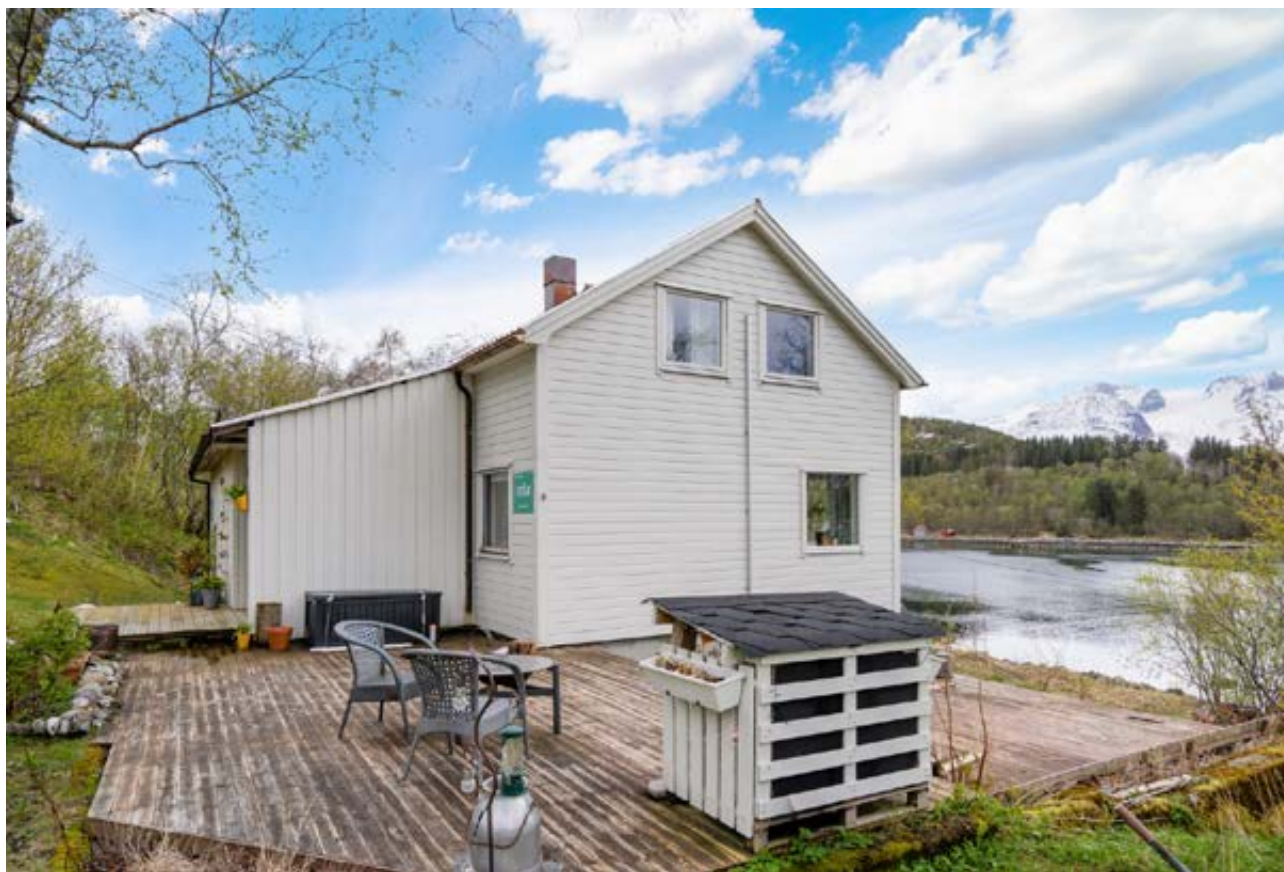
Terrasseplattingen mot boligen
