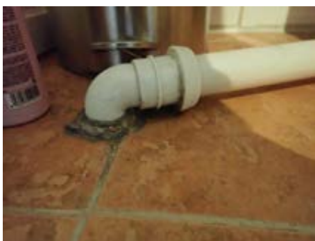
Rørgjennomføring i gulv.
