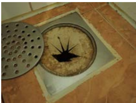
Ikke klemt ned i sluken i dusjhjørne.
