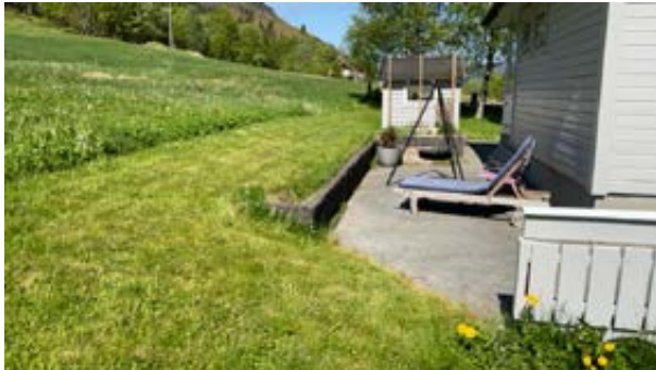
Terreng og betong terrasse har fall inn mot grunnmur.
