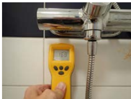
Ingen fukt i vegg
